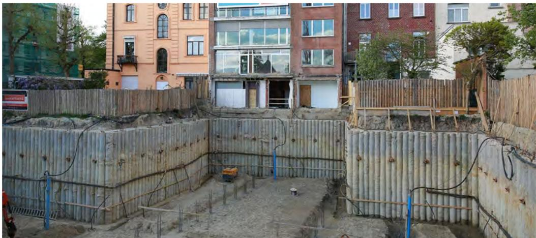
Figure 86 : Exemple de parois en pieux sécants
