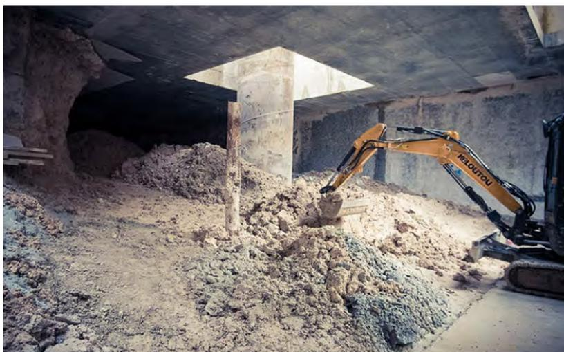
Figure 83 : Illustration d'un terrassement sous la dalle de couverture (en stross)
