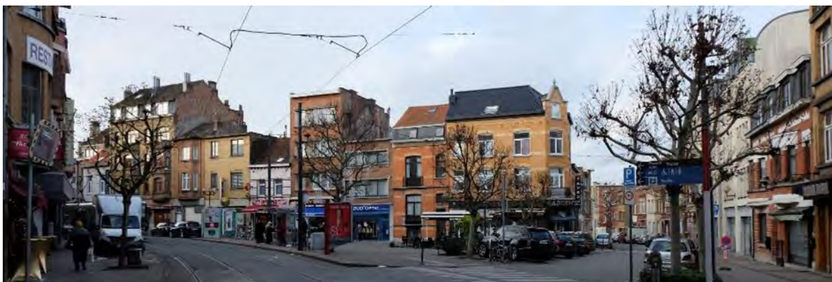
Figure 72 : Cadre bâti de type résidentiel bordant le nord de la place de la Paix (ARIES, 2020)
