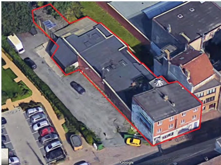
Figure 19 : Démolition des bâtiments existants (BMN, 2018)
