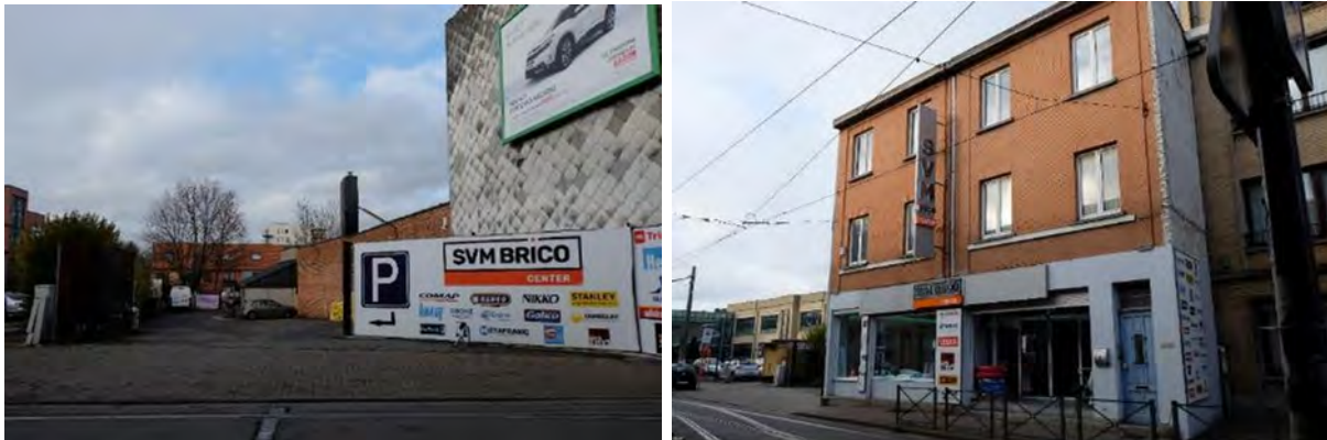
Figure 4 : Vue des bâtiments à démolir (ARIES, 2019)
