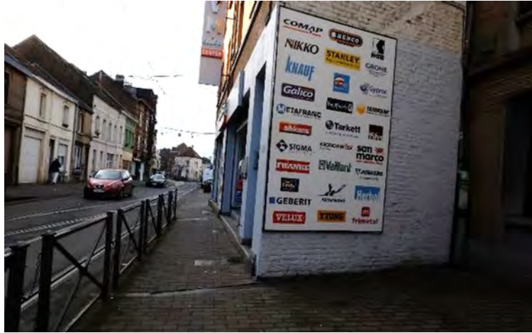
Figure 80 : Rétrécissement du trottoir au droit des bâtiments n°137-139, rue Edouard Stuckens (ARIES, 2020)
