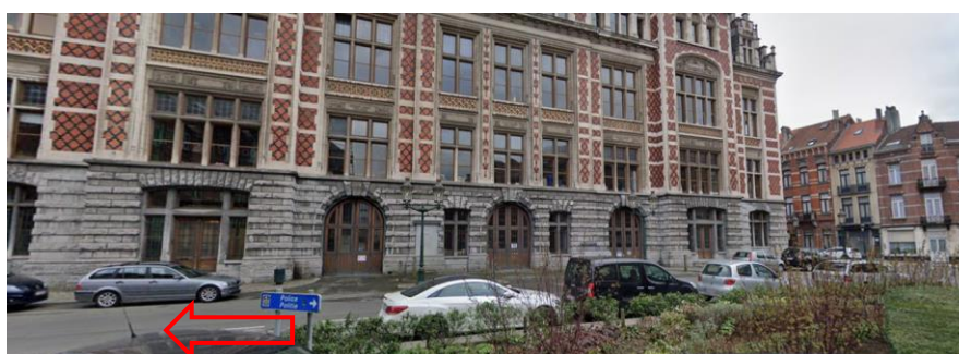
Accès livraisons à la maison communale
