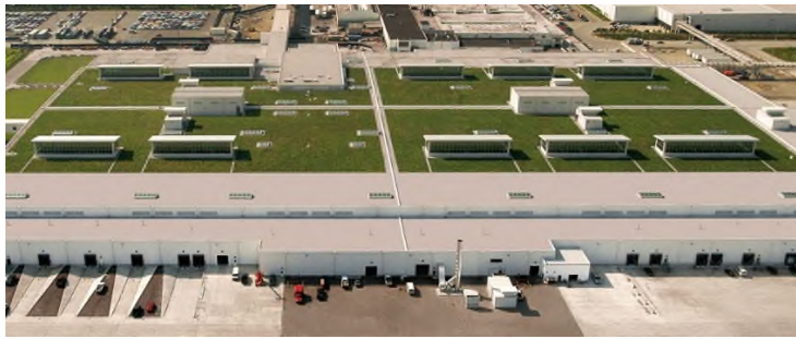
Figuur 279: Voorbeeld van een groen dak op een lichte constructie - Ford Motor Company's River Rouge Truck Plant ( www.greenroofs.com )
