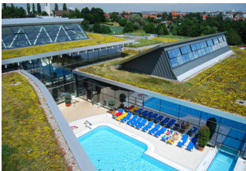
Figuur 281: Voorbeeld van de uitvoering van een groen dak op een lichte constructie – ( www.optigreen.fr )
