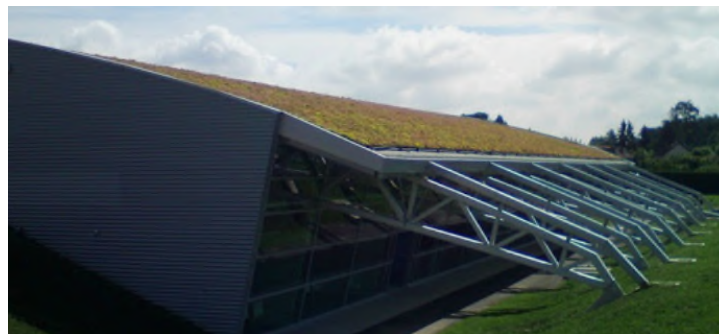
Figuur 278: Voorbeeld van een groen dak op een lichte constructie: Gymnase de St Genis Laval - Le Prieuré Vegetal i.D. ( http://www.vegetalid.fr )
