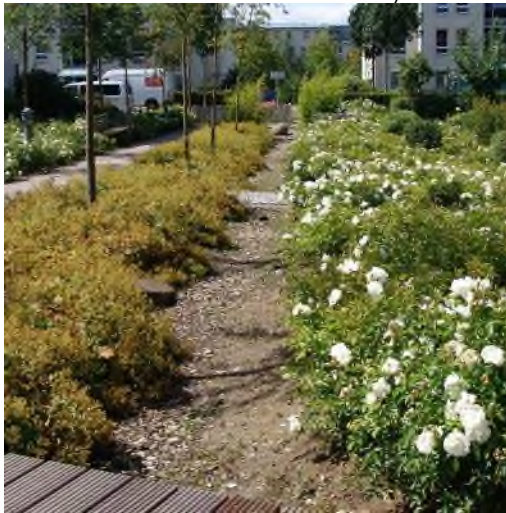
Gedeeltelijk beplante minerale infiltratiegracht (district Kronsberg, Hannover – Valérie Mahaut)
