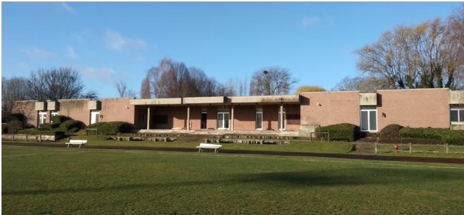
Figuur 71: Zicht op de oostelijke gevel van de kleedkamers (ARIES, 2020)
