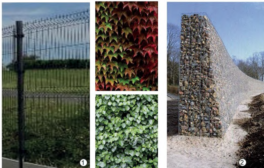
Figuur 92: Voorbeelden van een metalen omheining [1] en een muur van schanskorven [2] (BMN, 2017)
