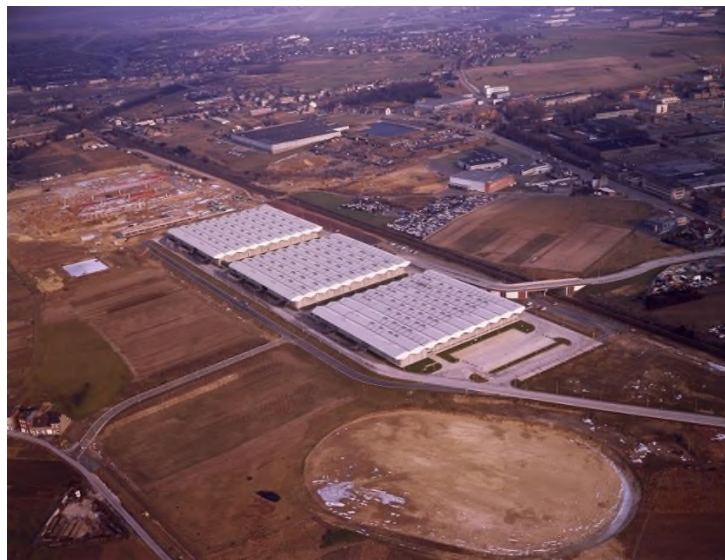
Figuur 57: Luchtfoto van de stelplaatsen voor bussen en de bouwplaats van het atletiekveld in de jaren 1970 (STIB/MIVB; ontleend aan BruCiel, 2020)
