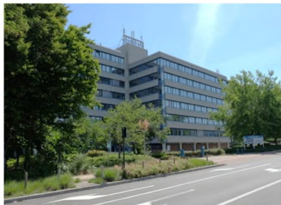
Figuur 61: Kantoorgebouw op de hoek van de Haachtsesteenweg en de Zweefvliegtuigstraat (ARIES, 2020)
