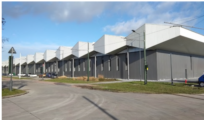
Figuur 63: Gebouw van de bestaande stelplaats van de MIVB (ARIES, 2020)
