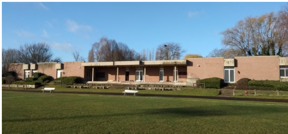
Figuur 9: Gebouw met de kleedkamers (ARIES, 2020)
