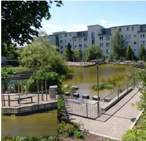
Waterretentiebekken (wijk van Kronsberg, Hannover – Valérie Mahaut)
