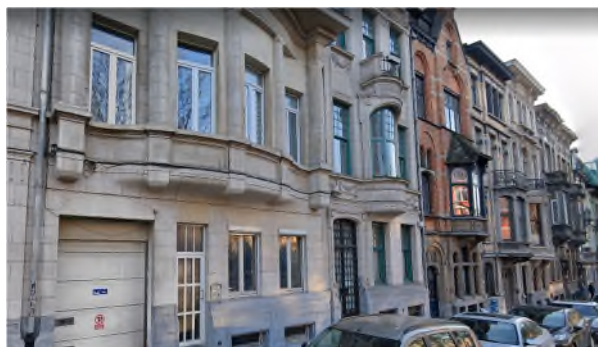
Figuur 190: Woningen Lambermontlaan
