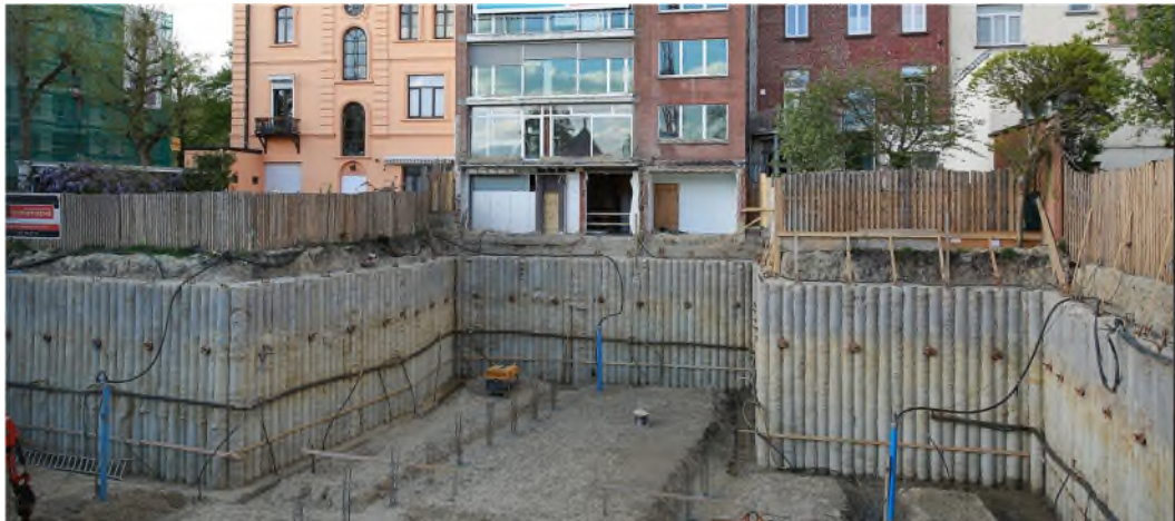
Figuur 86: Voorbeeld van wanden in secanspalen
