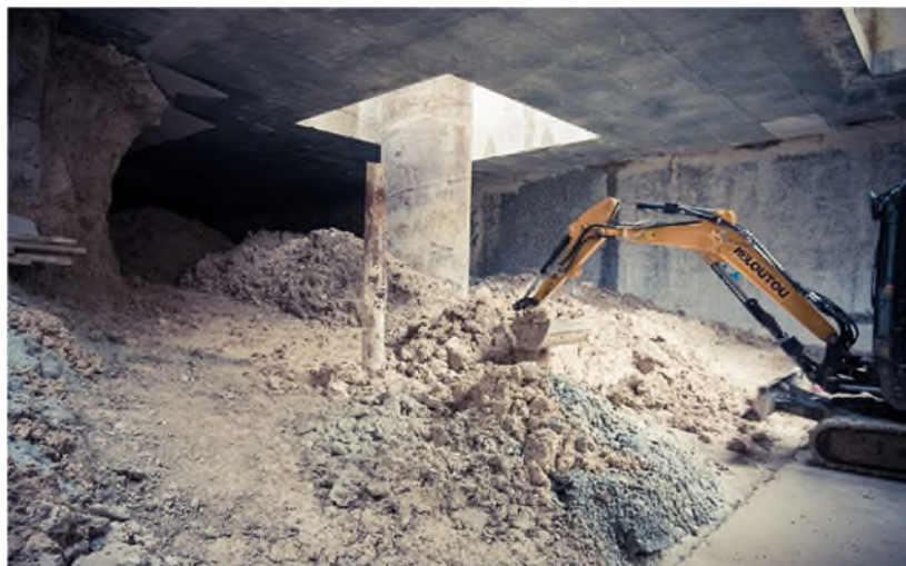
Figuur 83: Illustratie van grondwerken onder de afdekklaar (in Stross)
